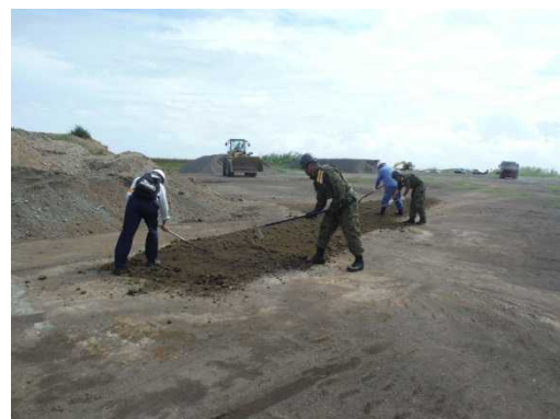
掘削した土砂を仮置き場で確認
