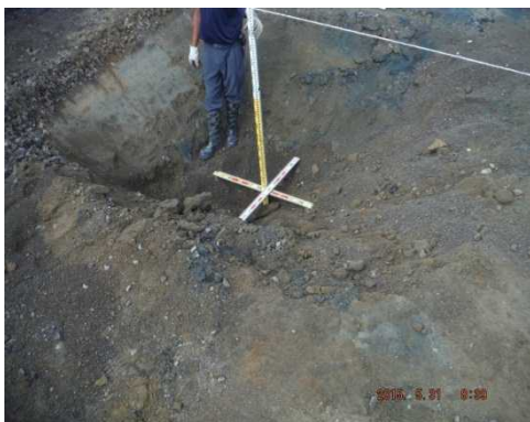
反応箇所の掘削
