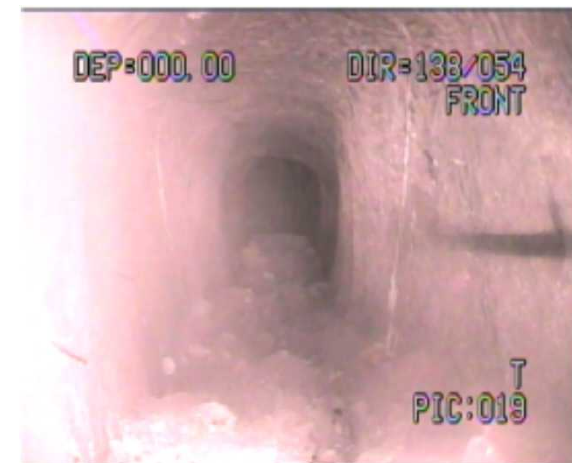
地下壕①の状況
