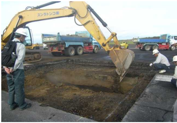
滑走路下の掘削
