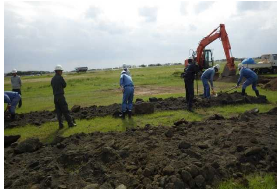
掘削した土砂を確認
