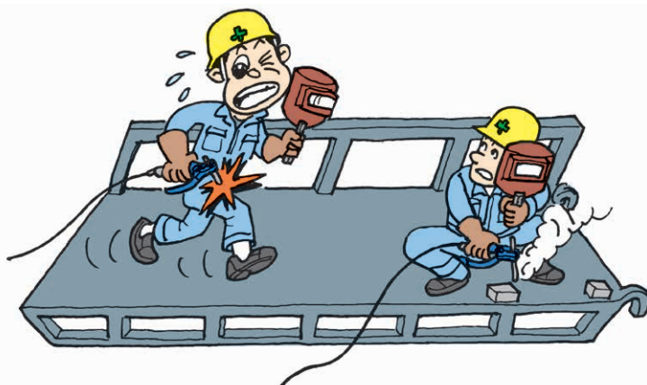
Bị điện giật vì que hàn chạm sườn trong khi chế tạo một dầm bằng thép
