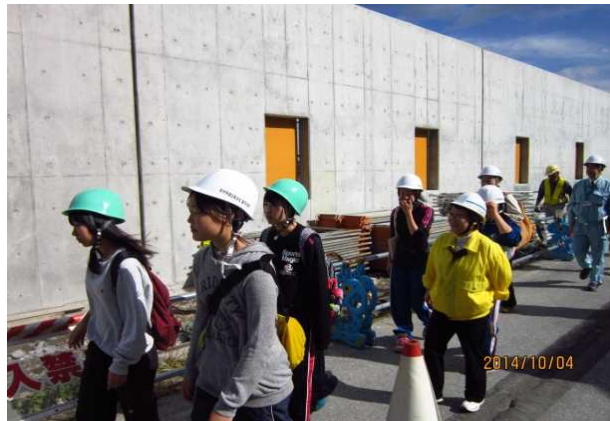
防潮堤建設現場を見学する生徒たち
