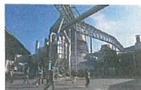
バイオマスツアー工場見学
