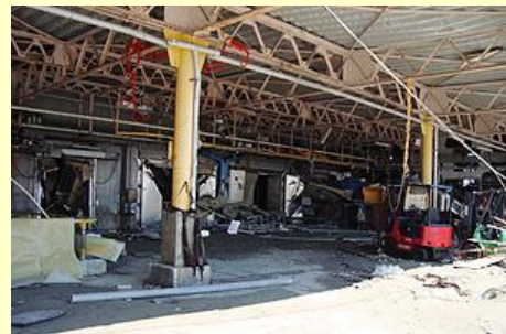
被災直後・冷蔵庫
