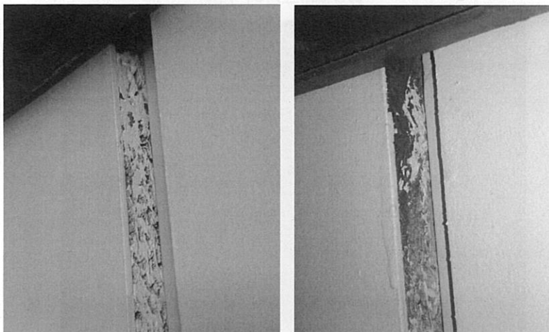
JIS A-5426(旧)スレート・木毛セメント積層板:木毛板の両側(または片側)にスレートが積層されている。木毛板部分には含まれない。
