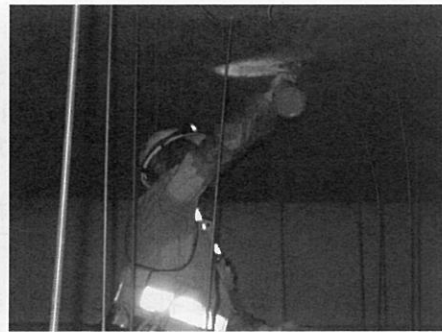
吹き付け材を試料採取した後に飛散抑制剤を散布(採取後の飛散防止)
