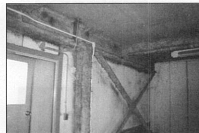
鉄骨の耐火被覆
