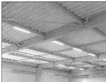
倉庫の折板屋根(屋根用折板石綿断熱材)
