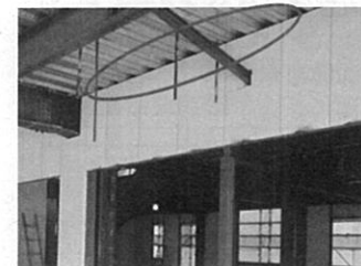
図1.15 ALC壁施工風景(隙間塞ぎ前)
