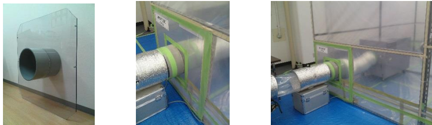
図－43 排気ダクト貫通パネル例
