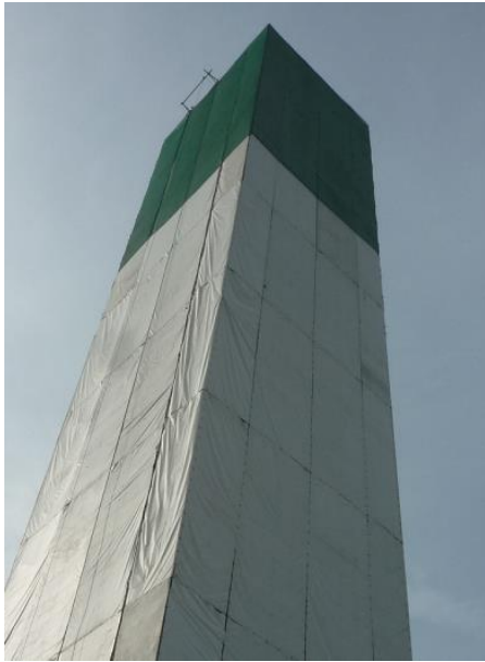
写真－１ 垂直ネットによる煙突頂部養生例
