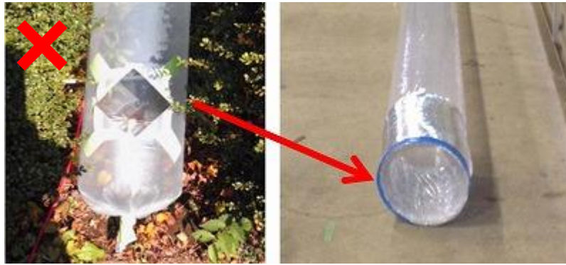
図-20 ビニールダクトの先端部分を環状の支え（アルミ製ダクト）を重ねて使用した例
