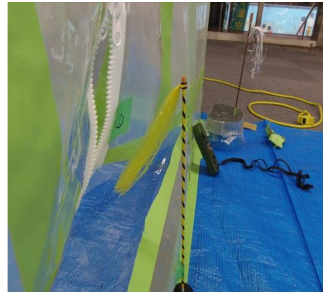
図-38 吹流しによる確認
