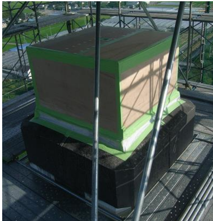
写真－３ 煙突開口部養生例
