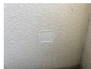
(固化および簡易補修後)
