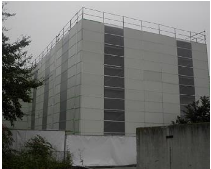
写真－２ 防音パネル／採光防音パネル施工例
