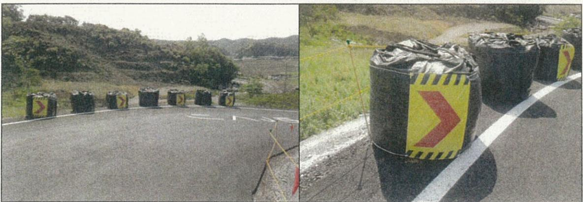
場内仮設道のカーブ内に注意喚起表示シートの付いた大型土嚢を配置した。
