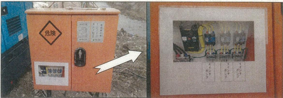
必要な正しい配線図を、写真に明示し、分電盤扉の表面に貼った。
