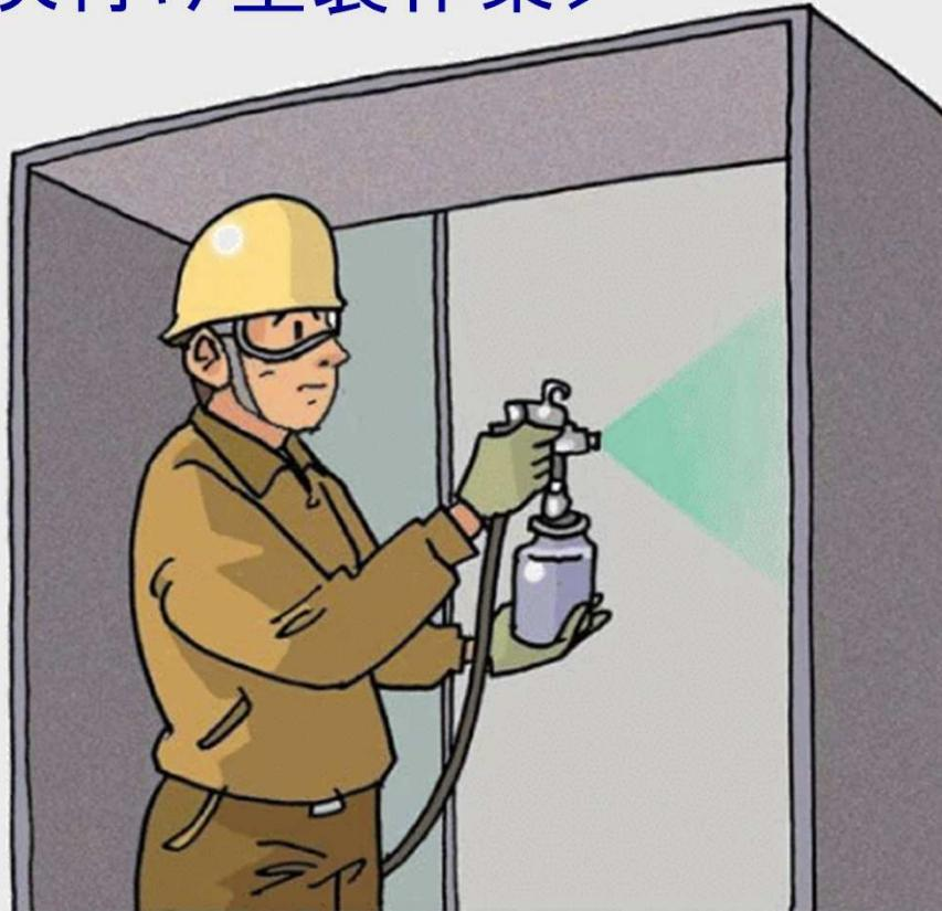
有機溶剤の入った塗料を使って吹付塗装作業をしています。
