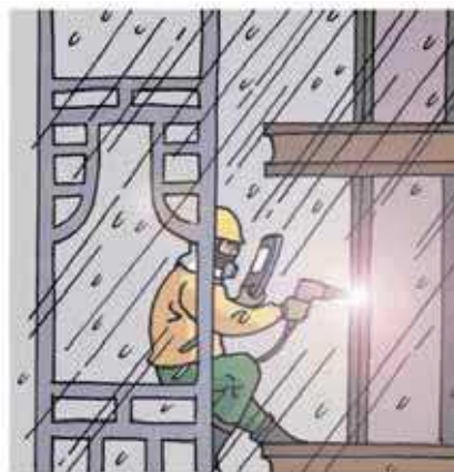
（高所でのアーク溶接）
