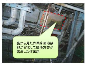
落下した作業床板(縦 70cm、横 100cm) 外周が全周腐食で減肉している。穴も 開いているが、原料粉が床上に堆積し ていて腐食が見えなかった。
