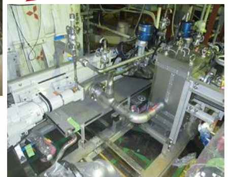
高線量率エリアに据付 (据付場所:5mSv/h)
