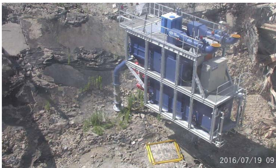
1F-1号機 原子炉建屋5階 大型ガレキ吸引機によるルーフ ブロック等の吸引作業状況 資料提供:清水建設(株)
