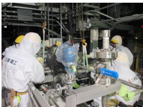
低線量率エリアで組立 (組立場所:0.07mSv/h)
