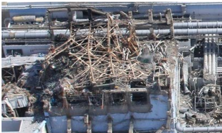
1F-3号機 原子炉建屋5階 事故直後の状況
