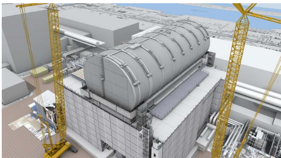
1F-3号機 原子炉建屋5階 燃料取出し用カバー設置イメージ図 資料提供: 鹿島建設(株)
