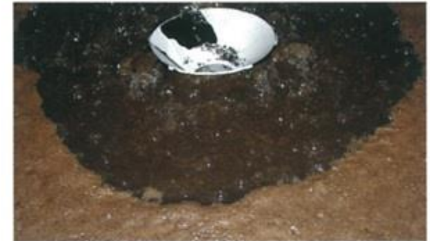
ろ材の空気洗浄状況
