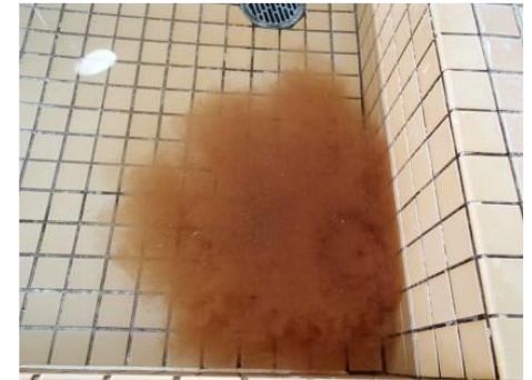
水位センサー配管から排出した汚れ
