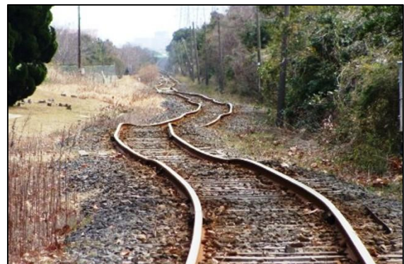
地震で線路が歪んだ大洗鹿島線（銚田市）
