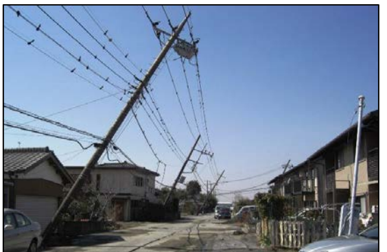
液状化で電柱が傾いた住宅団地（潮来市）
