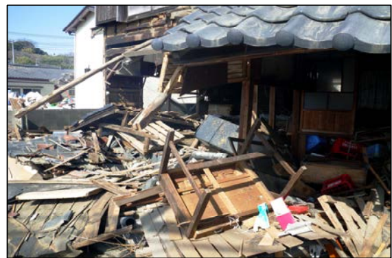
津波で倒壊した住宅（北茨城市）
