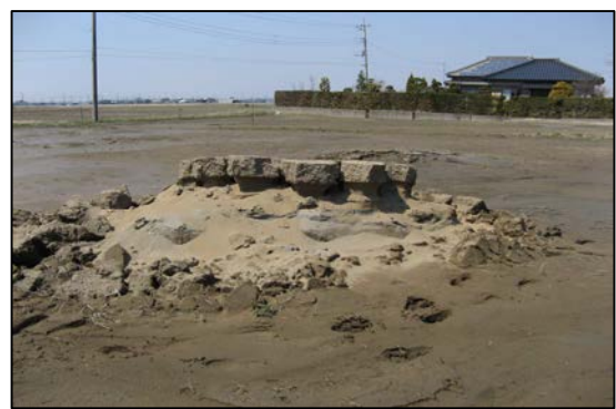
液状化により噴砂した農地（稲敷市六角地区）
