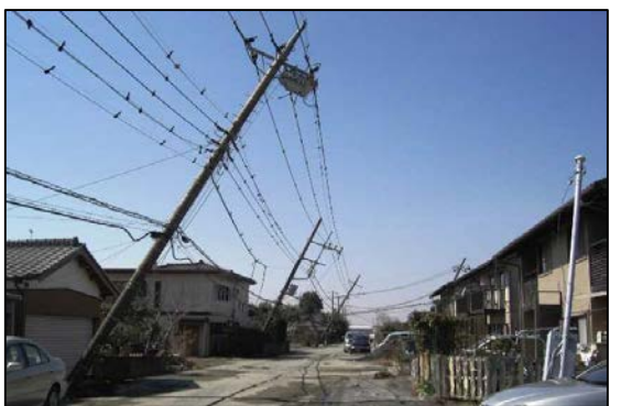
液状化で電柱が傾いた住宅団地（潮来市）
