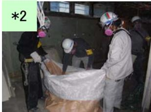
ビス抜き作業でも湿潤化が必要、フレコンバックへの梱包作業では発じんを抑えるための十分な湿潤化の徹底が必要
