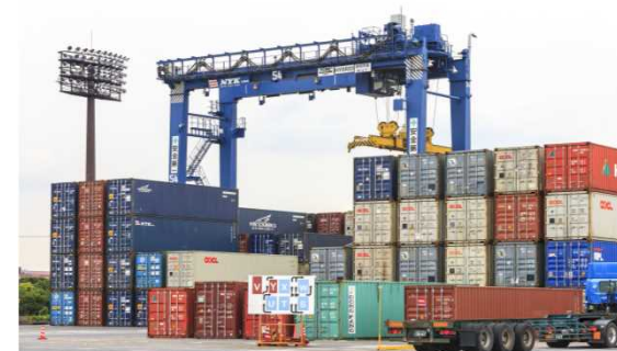
トランスファークレーンの外観
