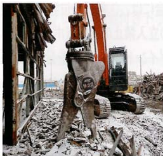
コンクリート圧砕機 (コンクリート構造物を砕く)
