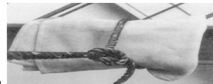
切断防止措置（養生）の例
