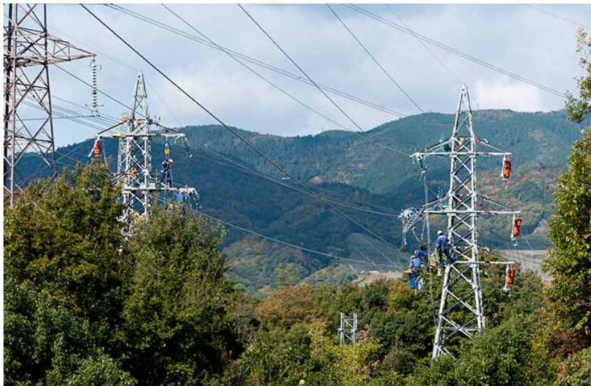
(送電設備の復旧作業訓練)
