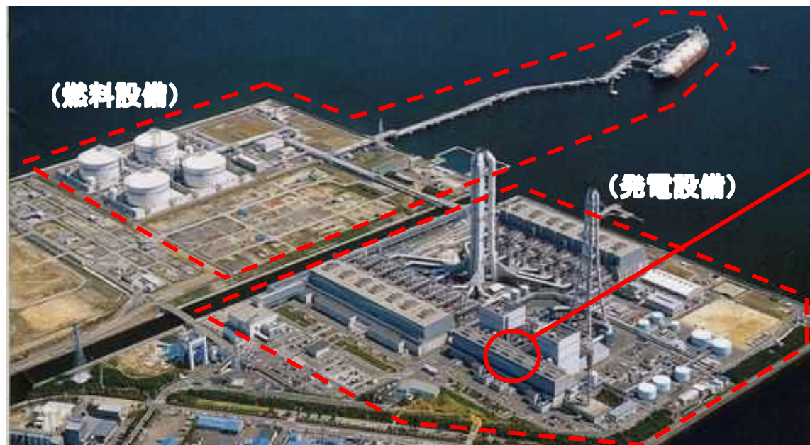
(火力発電設備・燃料設備の全景)
