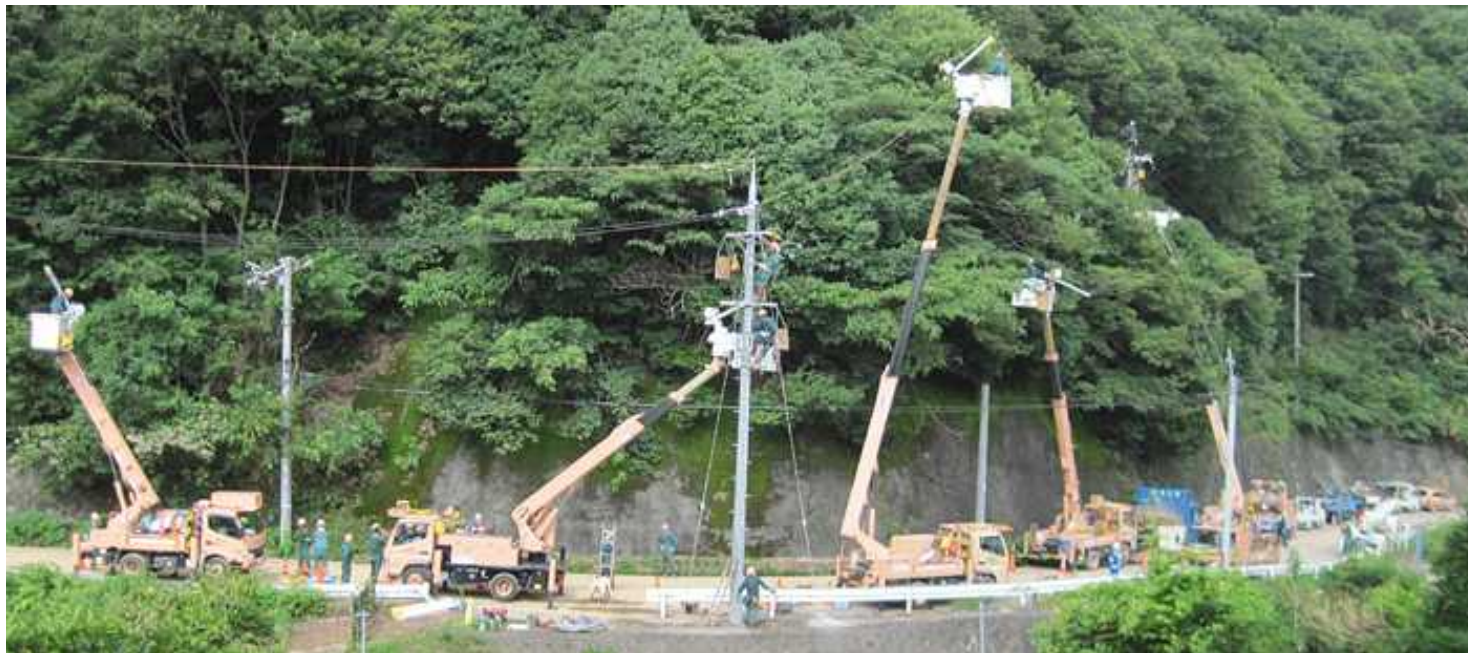
(配電設備の復旧作業)
