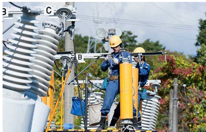
(変電設備の復旧作業訓練)
