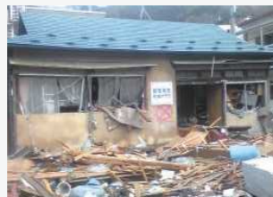
津波の被害を受けた学童保育施設 (写真提供：和田雅己)
