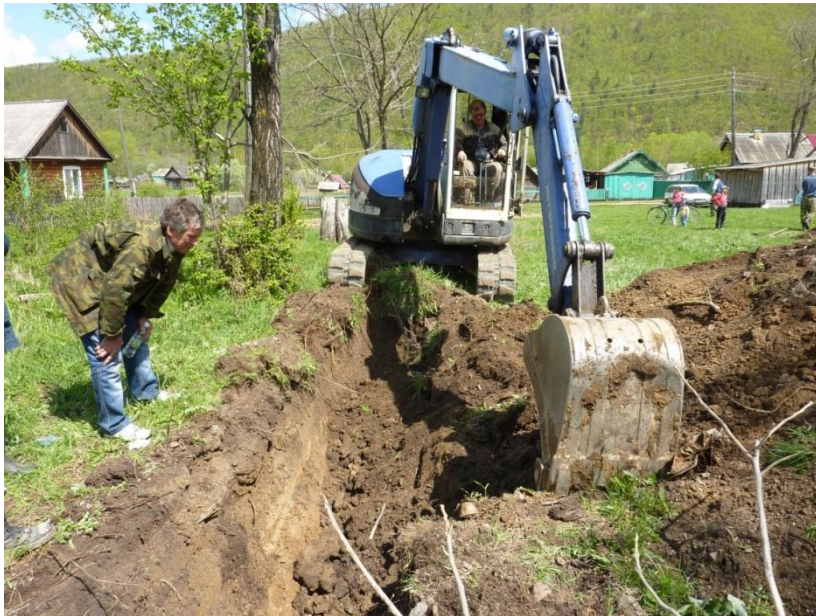
重機による作業
