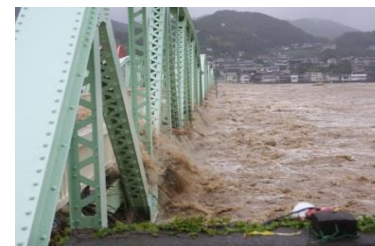
台風12号による被害
