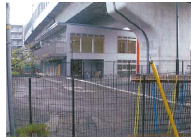
▲道路高架下の 屏風ヶ浦はるかぜ保育園の外観
