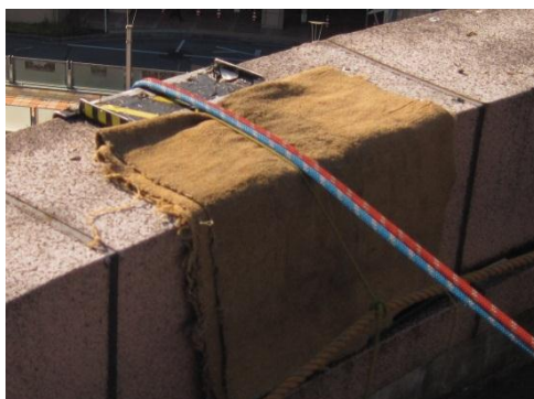
パラペット（建築物の端部）の養生
