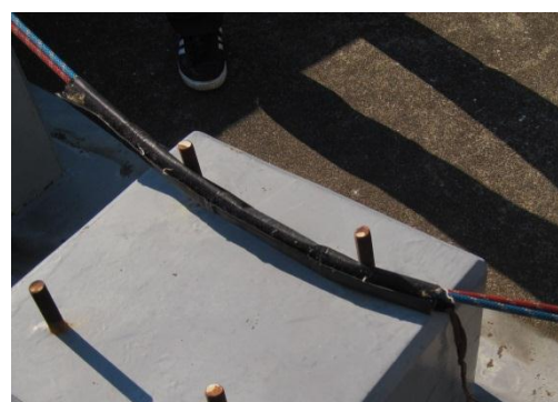
構造物の養生（巻き付け型養生材使用）
