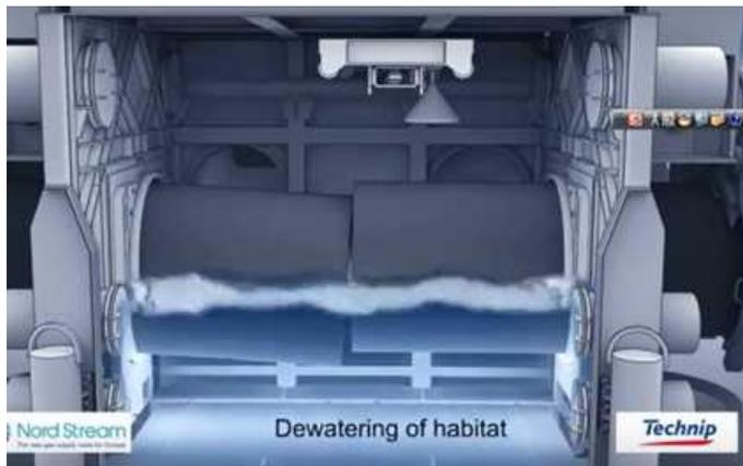
ドライチャンバー内排水状況(Technip)
