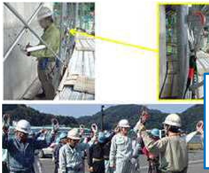
安全帯の使用を意識するように、高所作業時の安全帯の使用状況が遠くからでも認知できる。
