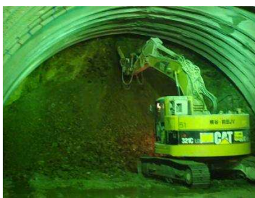
図 2.1 掘削作業の状況
