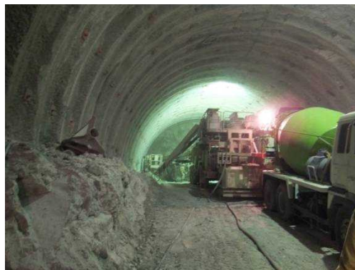
(コンクリート等吹き付け作業時)
