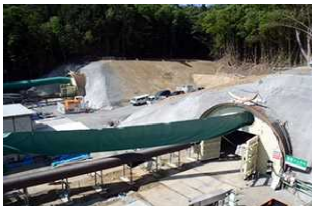
図 3.5 測定現場の抗口付近の外観
