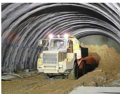
図 2.2 積み込み又は積み卸し作業の状況
