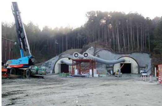
図 3.1 測定現場の抗口付近の外観
