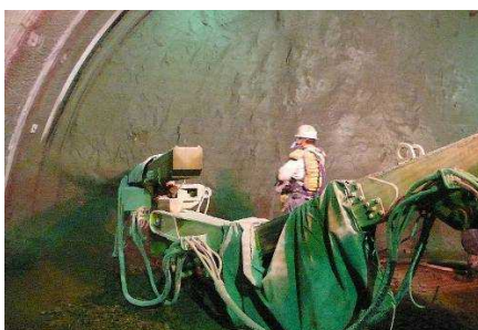
図 2.3 コンクリート等吹き付け作業の状況
