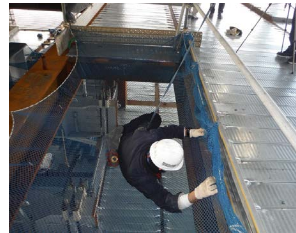
写真3 防網上に墜落した被災者が自力で脱出しようとしている様子(模擬)
