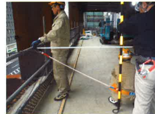
(ランヤード1.5mでの実証: 床面作業)
