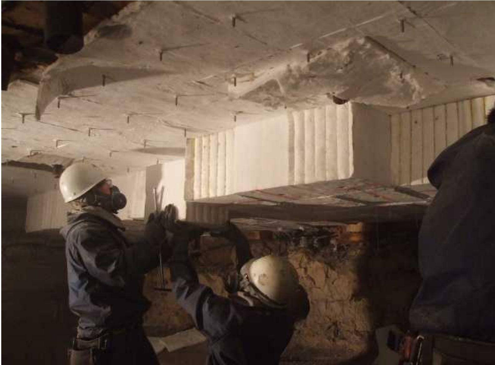
セラミックファイバー ブロック施工
