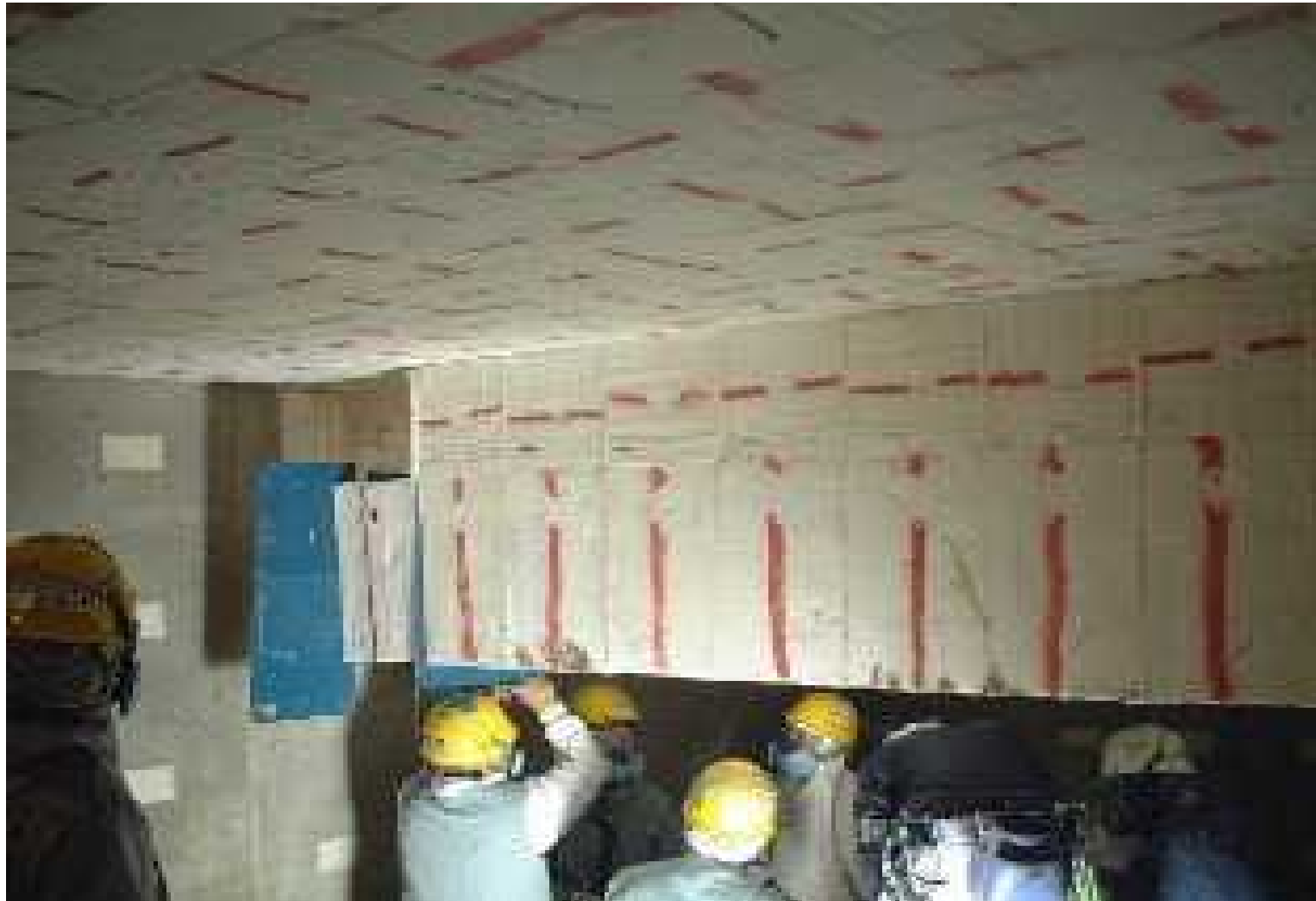
セラミックファイバー ブロック施工
