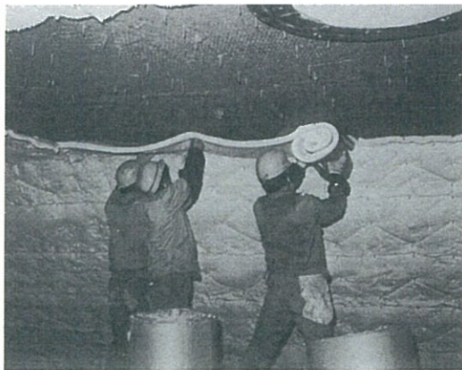
ファイバーを炉体に設置している現場写真
