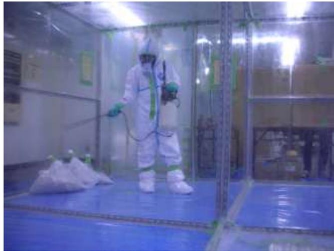
写真7 粉じん飛散抑制剤噴霧（2回目：清掃後）
