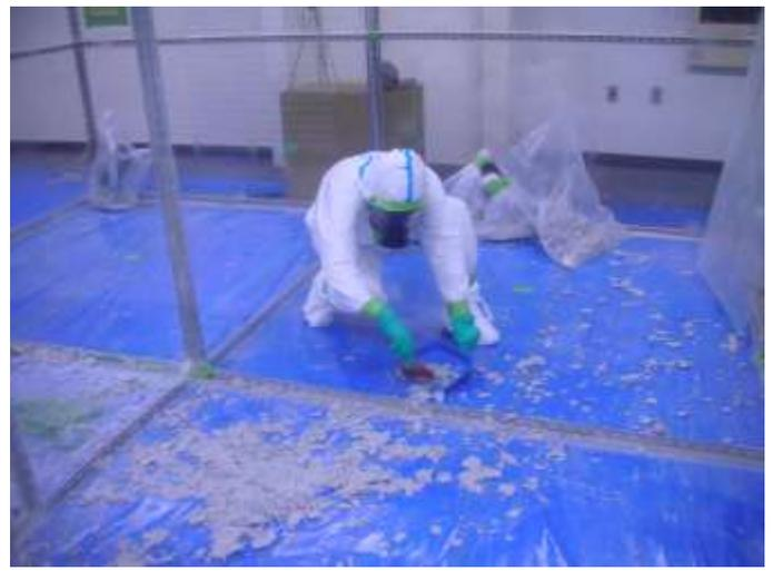
写真6 粉じん飛散抑制剤噴霧の清掃作業
