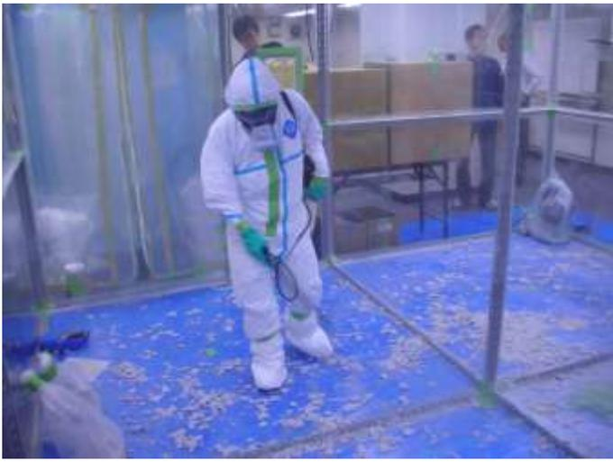
写真5 粉じん飛散抑制剤の噴霧（1回目）
