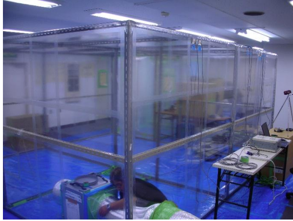
写真3 作業室の外観
