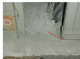
写真Ⅱ-12 電気配線部分隙間閉鎖
