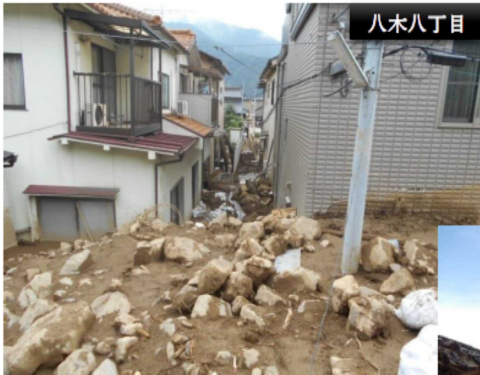
土石流による家屋の倒壊 [いずれも広島市消防局提供]
