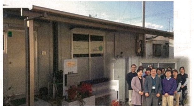
祐ホームクリニック石巻の外観
