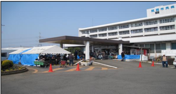
○筑西市民病院（筑西市） 屋外仮設テント、プレハブでの診療、本館使用不可
