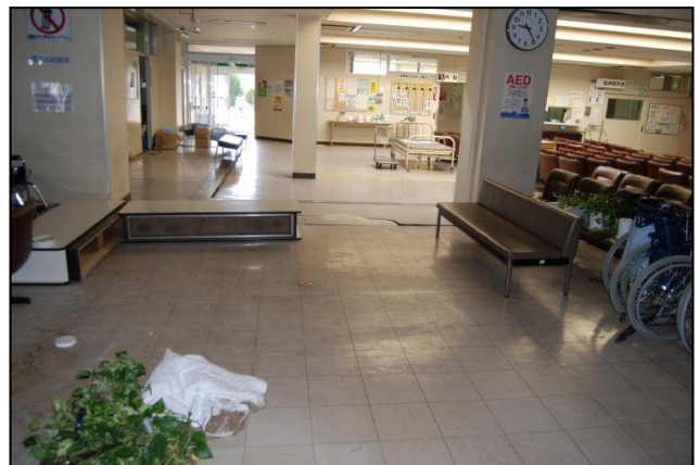
○北茨城市立総合病院（北茨城市） 本震（3/11）、余震（4/9）により地盤沈下を繰り返し、
