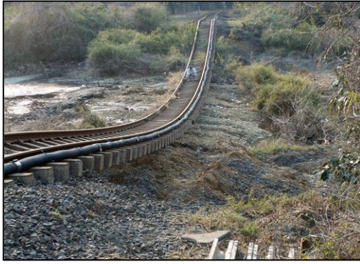
■ 湊線（ひたちなか市） 大規模な地盤沈下により、線路も大きく歪んでしまった。
