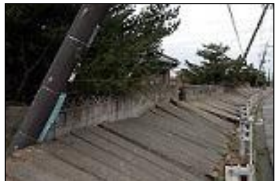
■潮来市（日の出地区） 町全体が地盤沈下し、アスファルトが波打って、電柱も傾いたまま。
