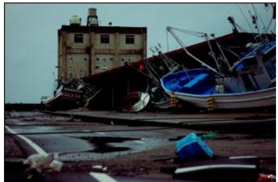
■大津港（北茨城市） 6メートルを超える津波を受け、甚大な被害が出ている。
