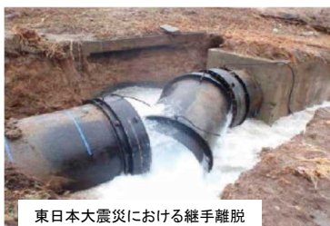
東日本大震災における継手離脱
