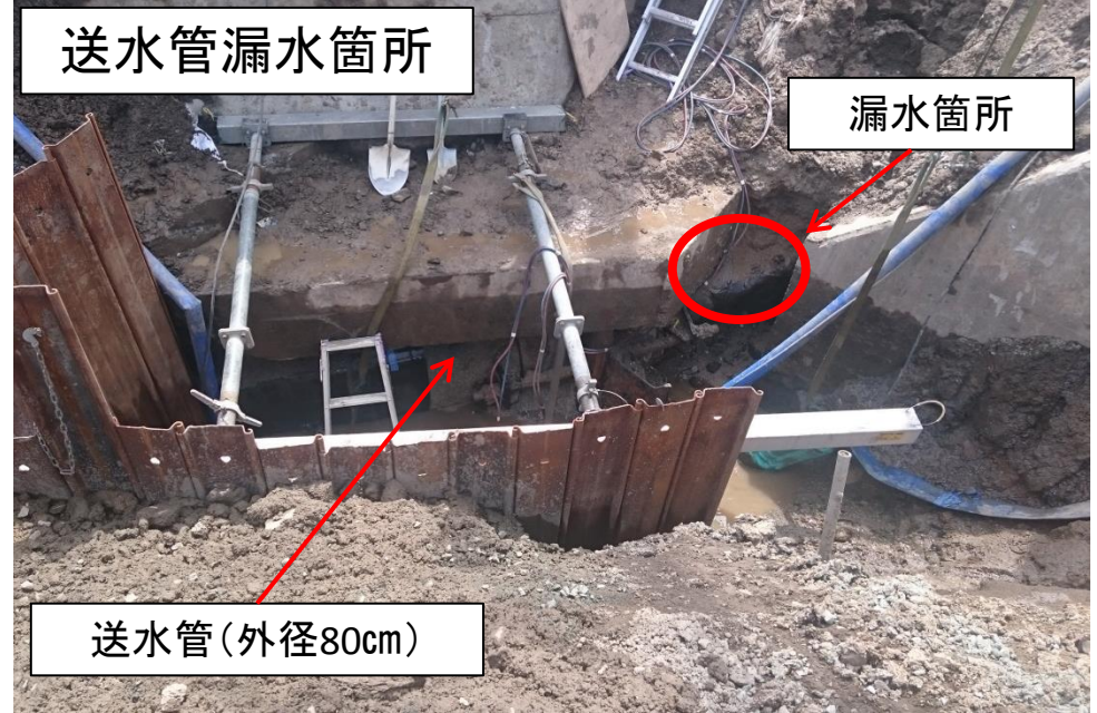
送水管漏水状況
