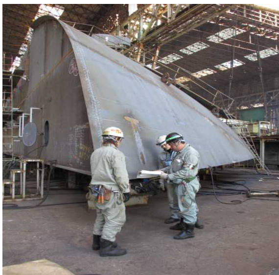
ブロック全体精度の確認作業 (黒ヘルメットが山根氏。後進へ精度チェック時のポイントを指導中)
