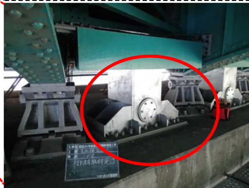
支承補強構造(橋軸直角方向)
