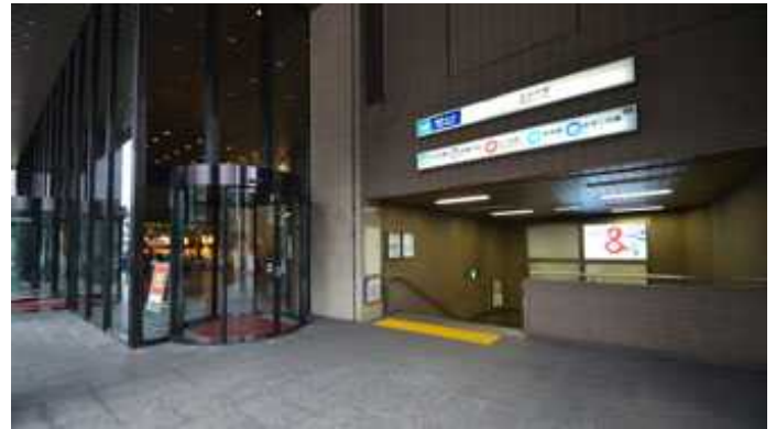
ビル側 地下鉄出入口
