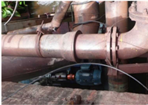
Foto 1 Bomba para toma de agua instalado bajo la muelle Foto 2 El río Paraguay utilizado como fuente de agua
