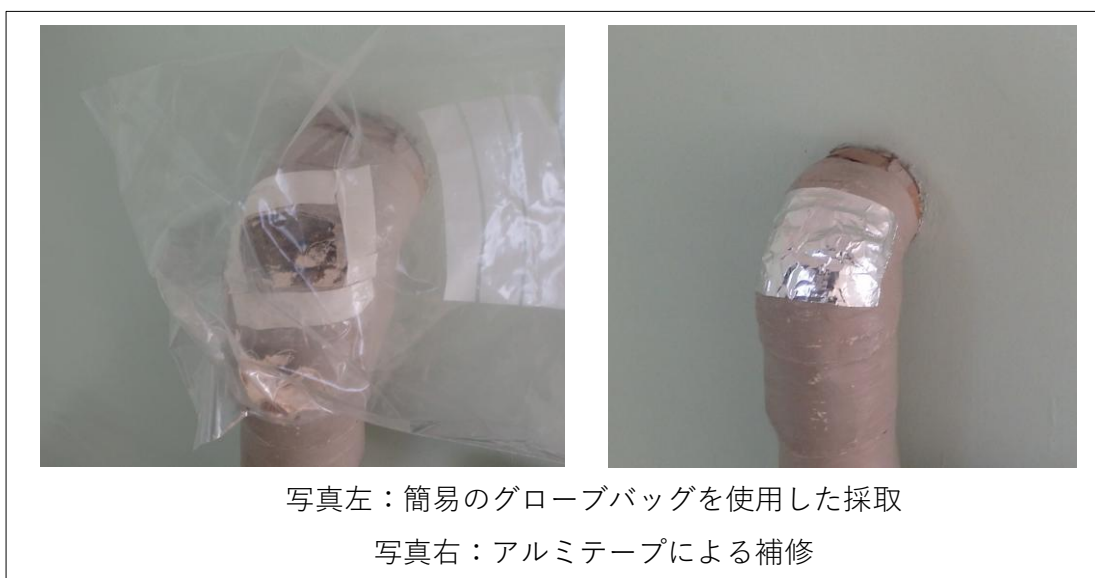
図3.22 配管保温材の採取
