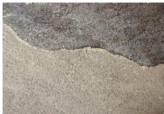
図 3.20 吹付け耐火被覆の試料採取箇所
