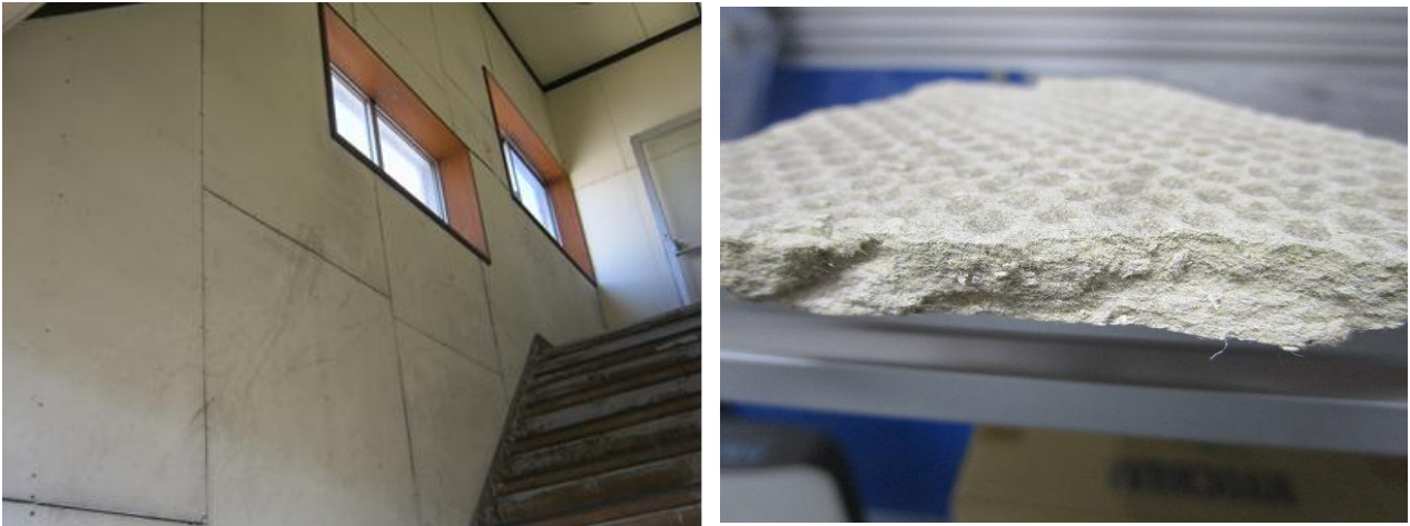
図 2.30 石綿含有パルプセメント板の施工例（左）と建材の近撮（右）
