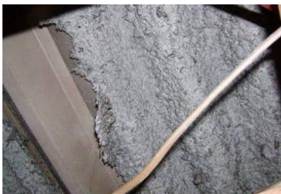
図 3.20 吹付け耐火被覆の試料採取箇所
