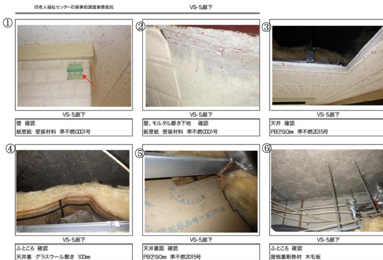
図 4.4 調査状況写真帳（判断根拠写真帳）（建築物の例）
